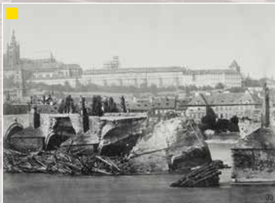
Durch Hochwasser beschädigte Prager Karlsbrücke, 4. September 1890. Unbekannter Autor, © Sammlung Scheufler
